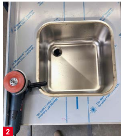
2 Le contour est poncé avec une meuleuse d'angle et un disque en fibre 3M 787C
