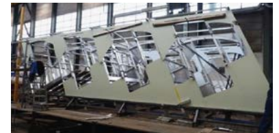
Seitenbleche werden auf das Grundgerüst geklebt
