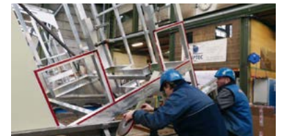
Doppelseitiges Hochleistungs-Montage-Klebeband wird aufgeklebt und mit der Anpressrolle angedrückt
