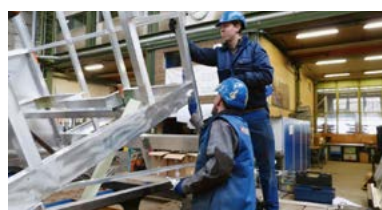
Après nettoyage avec le dégraissant de surfaces 3M, le primer 3M est appliqué
